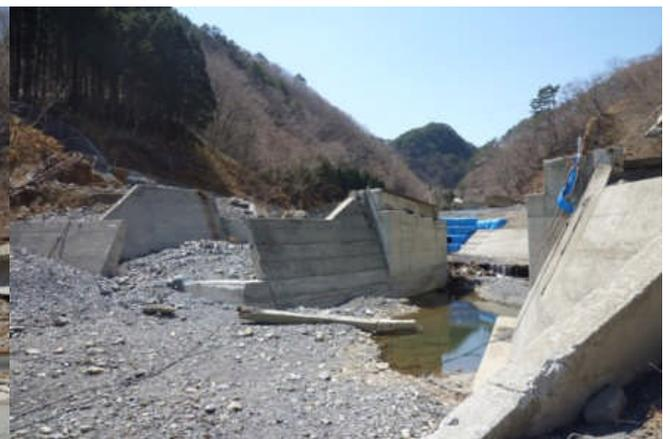
完全に破壊された三陸鉄道橋(田野畑村)
